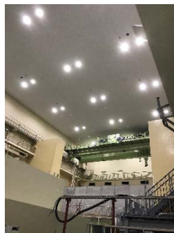
<高天井照明更新>
