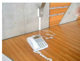
屋内運動場に 電話回線の設置
