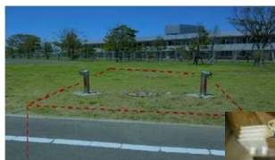
耐震性貯水槽
