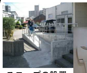
スロープの設置
