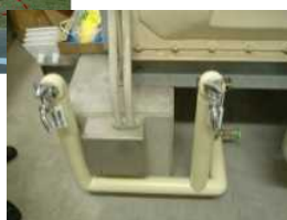
受水槽に蛇口を設置
