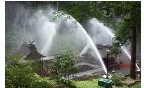
≪消火設備(放水銃)の設置≫
