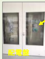
配電盤の扉にガラスを入れて、中が見えるように工夫されている。
