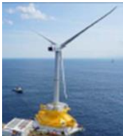
浮体式洋上風力発電設備
