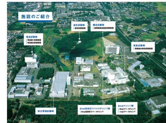
筑波宇宙センター・相模原キャンパス (衛星システム環境試験設備)
