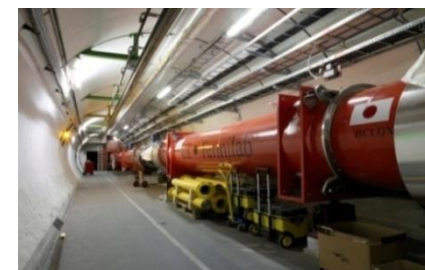
陽子ビームの衝突頻度の向上に重要な役割を果たすLHCビーム衝突点超伝導電磁石
