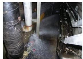
配管の破損による水漏れ
