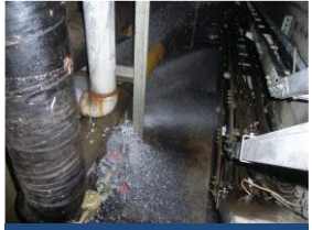
配管の破損による水漏れ
