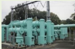
変圧設備、特高受変電設備、配線等を再生・強化
