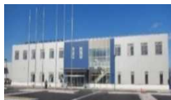
廃炉国際共同研究センター(CLADS) 「国際共同研究棟」
