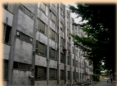
外壁の落下の危険
