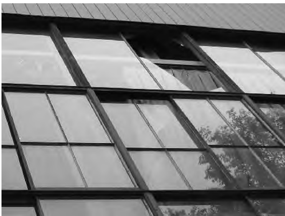
写真 4.13 はめ殺しのスチールサッシである窓ガラスの被害例
