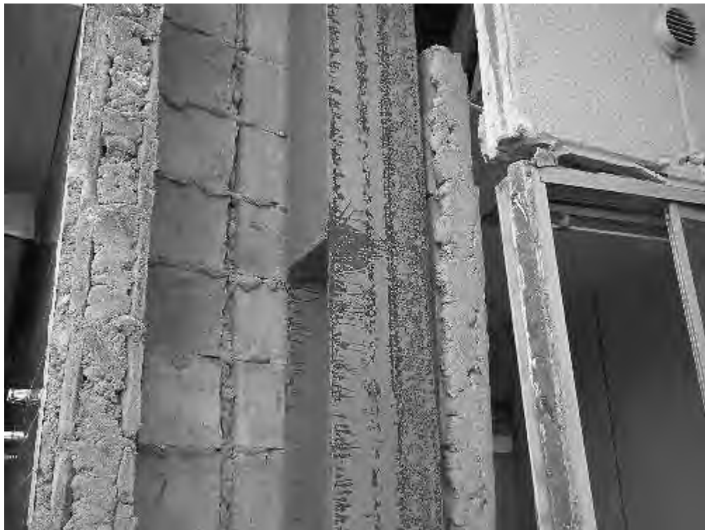
写真 4.16 コンクリートブロック壁の例
