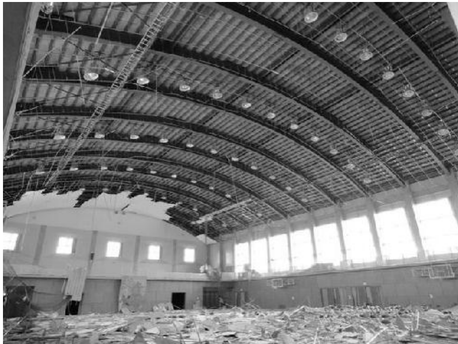
写真 4.9 耐震化されていない天井の崩落
