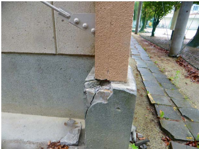
写真 4.5 耐震補強済みの体育館で発生した露出型柱脚における側方破壊
