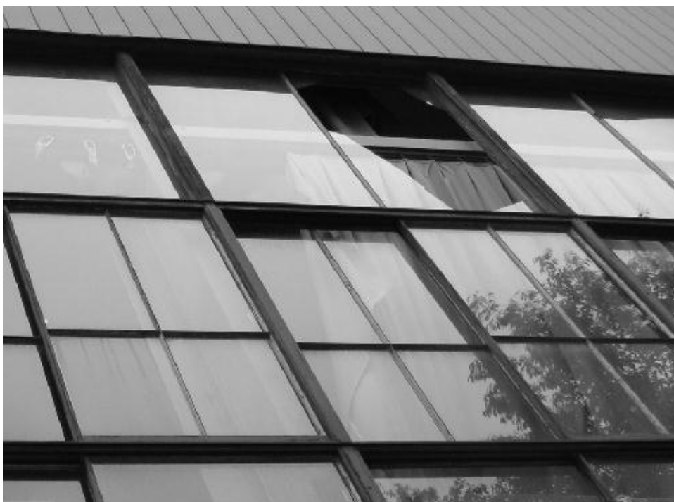
写真 4.13 はめ殺しのスチールサッシである窓ガラスの被害例
