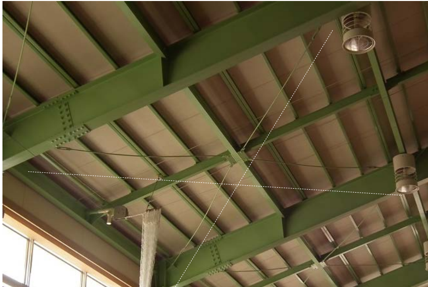
写真 4.8 たわみの見られる筋かいの例
