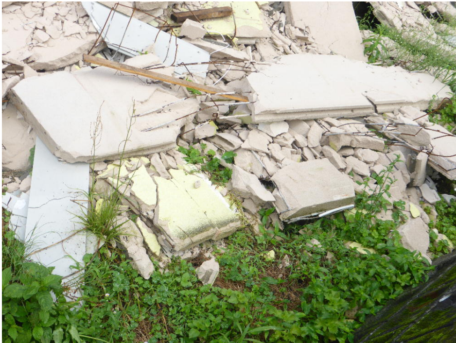
(b) 脱落した ALC パネル
