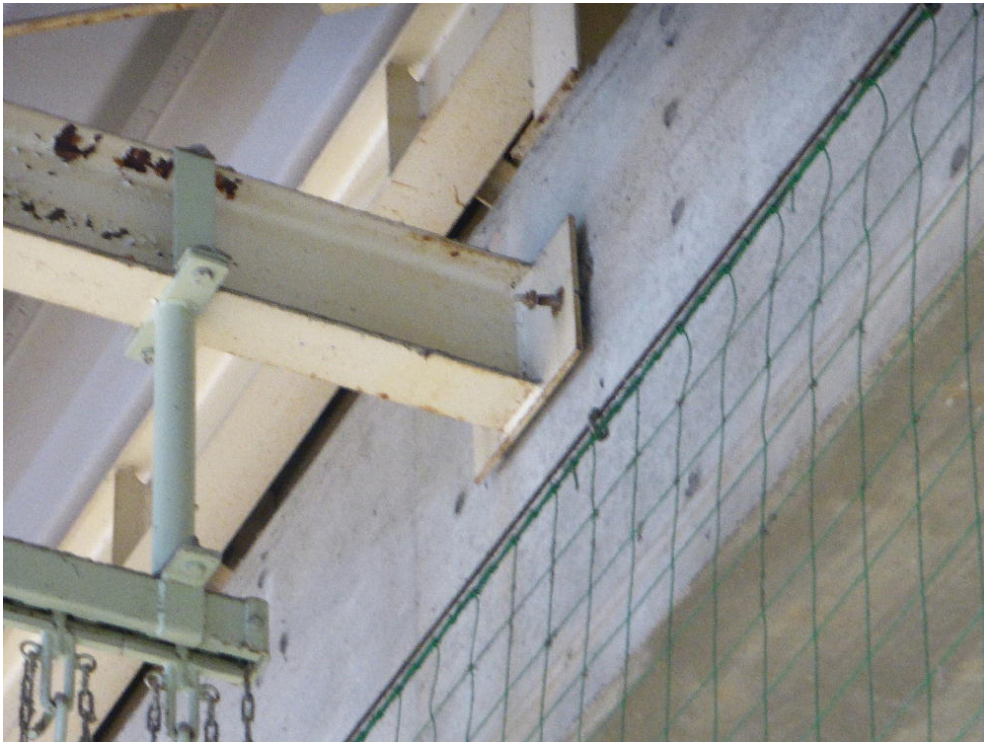
(a) あと施工アンカーの抜けだし
