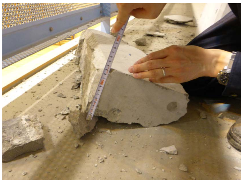
写真 4.6 鉄骨置屋根定着部における側方破壊 (参考：耐力度調査では鉄筋コンクリート構造として評価する部位)
