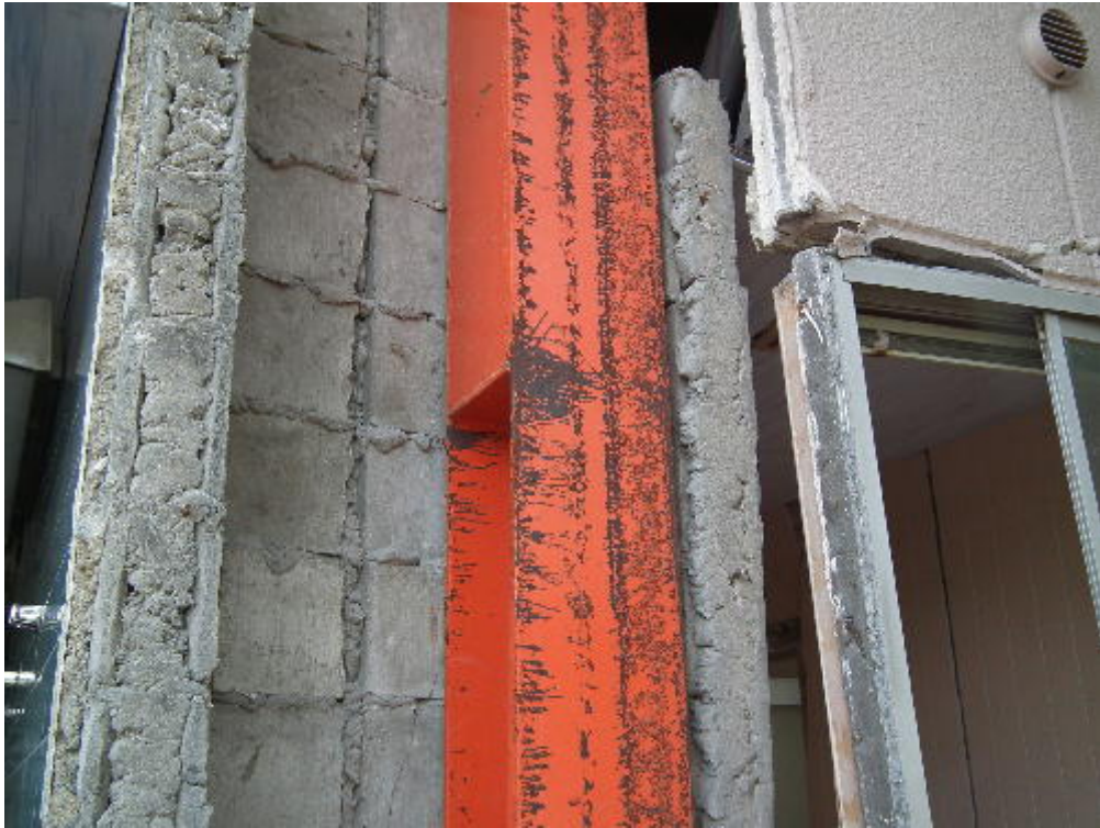
写真 4.16 コンクリートブロック壁の例
