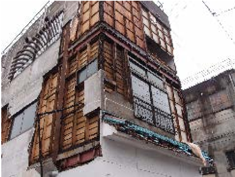
(a) ラスモルタル外壁の脱落
