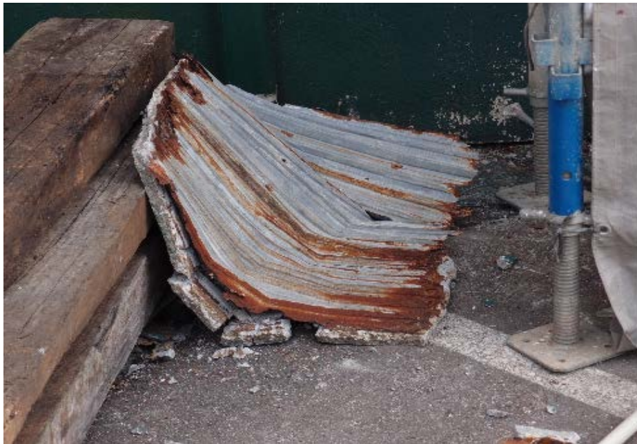
(b) ラスシートの腐食
