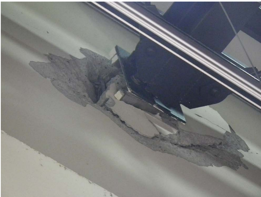
(b) コンクリートの破壊
