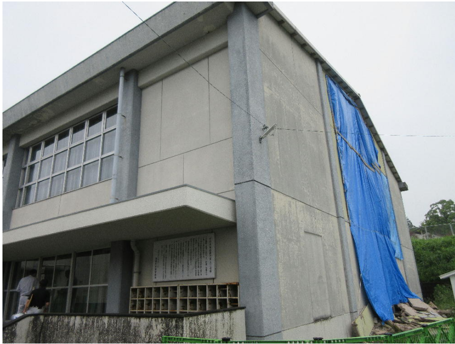
(a) 外壁が脱落した体育館の妻面
