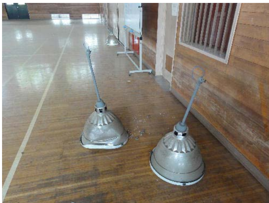
写真 4.14 落下した照明設備
