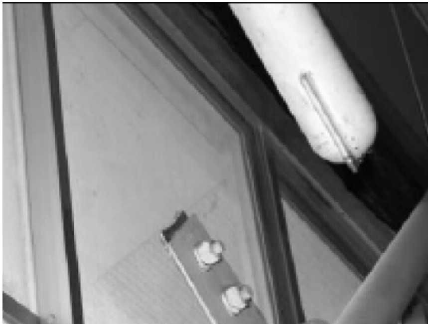
写真 4.2 新耐震設計基準の体育館における鋼管に一枚のガセットプレートが割り込まれた筋かいのガセットプレートでの破断
