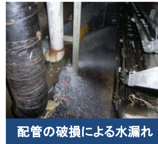
配管の腐食
