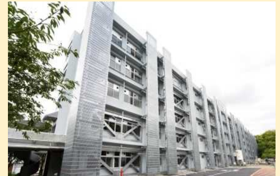
外壁落下等の重大事故を防止
