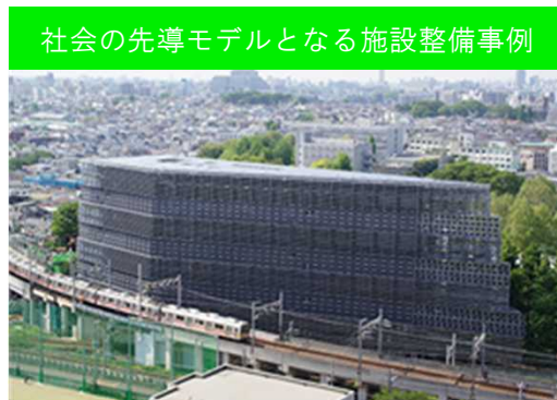
建物外壁に太陽光パネルを設置、建物で使用する電力は、ほぼ自給自足できる
