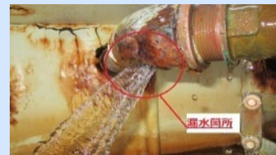
配管の破損
