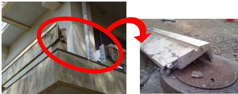
老朽化により手すりが落下
