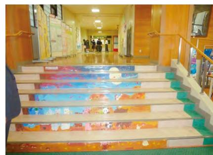
児童が利用する階段について、安全に昇降できるよう段差（けあげ）の寸法を小さくする改修を行っている
