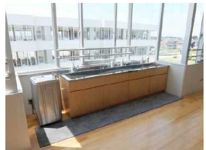
▲ 廊下に設置された手洗い。利用者が動線と交錯しないよう配慮。
