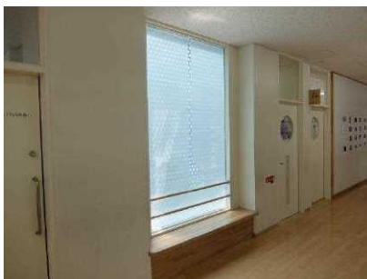
▲改修時に採光窓をつくったことで中廊下でも明るい校内となっている。
