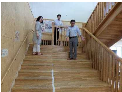
▲上下階をつなぐ室内階段は、一部蹴上げの高さを変えて座席にもなる部分をつくっている。
