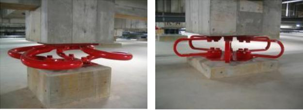
**鋼棒ループダンパーの設置例**      **U型ダンパーの設置例**
