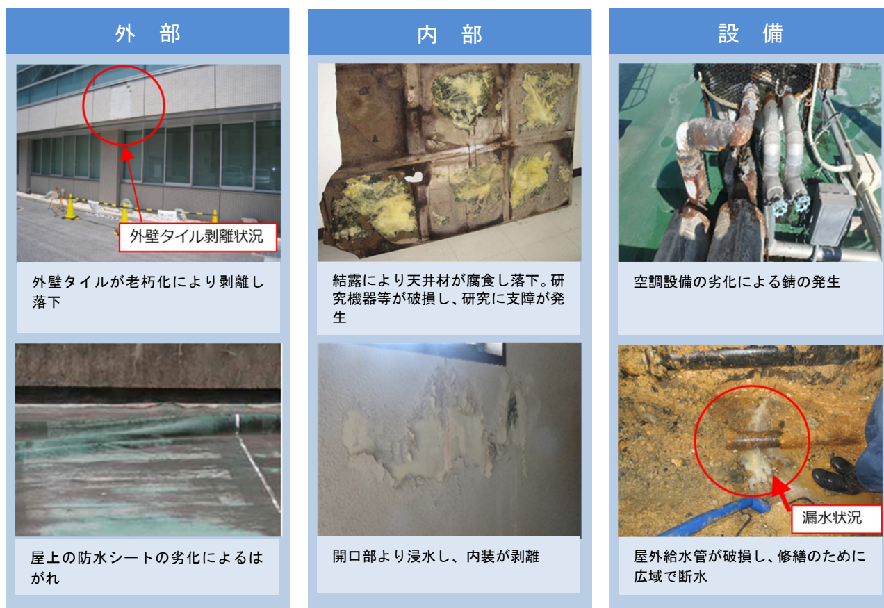
図4 施設・設備の老朽化の状況
