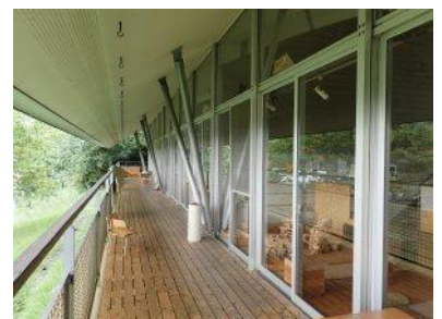
▲豊かな自然に面した半屋外空間
