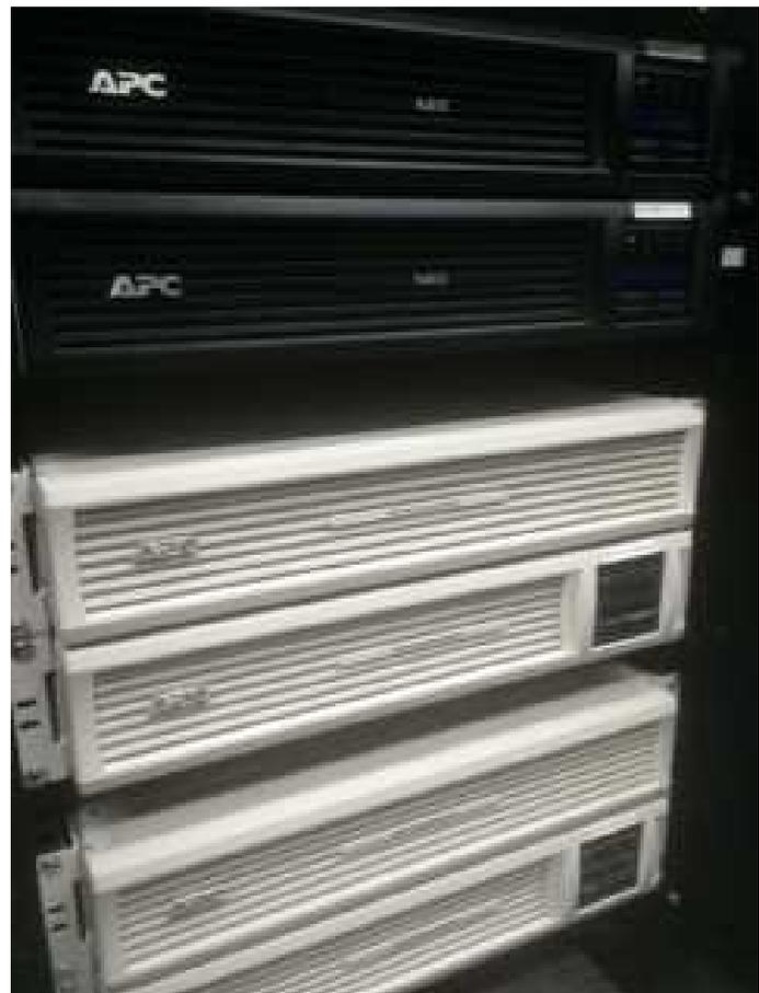
図2: 1台毎に無停電電源設備を設置したサーバー
