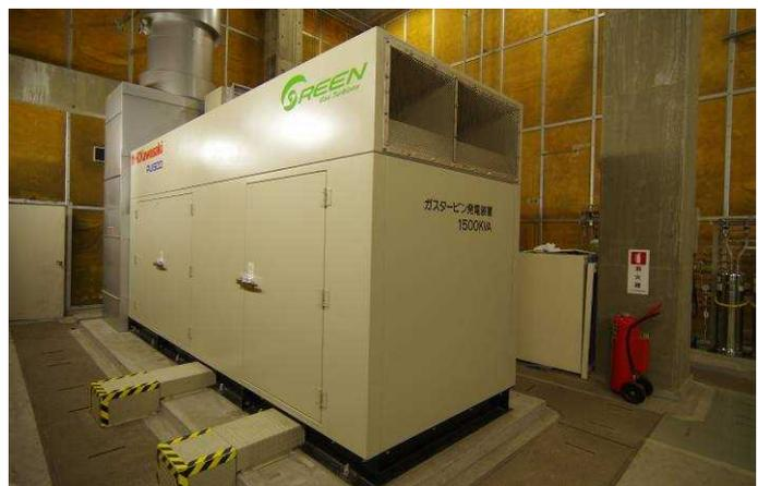
図4: ピークカットにも活用する 1,500kVA の非常用発電機
