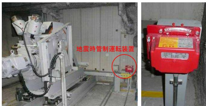
図2:病棟エレベーター機械室の巻き上げ機と地震時管制運転装置
