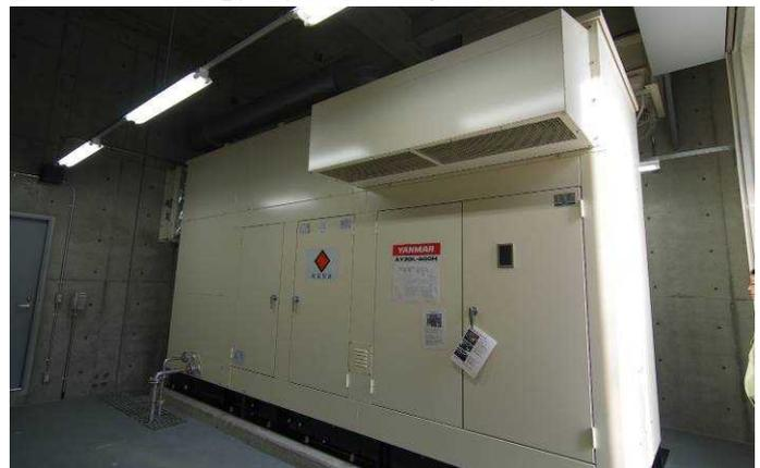
図2: 防潮堤内に新設された 500kVA の発電機
