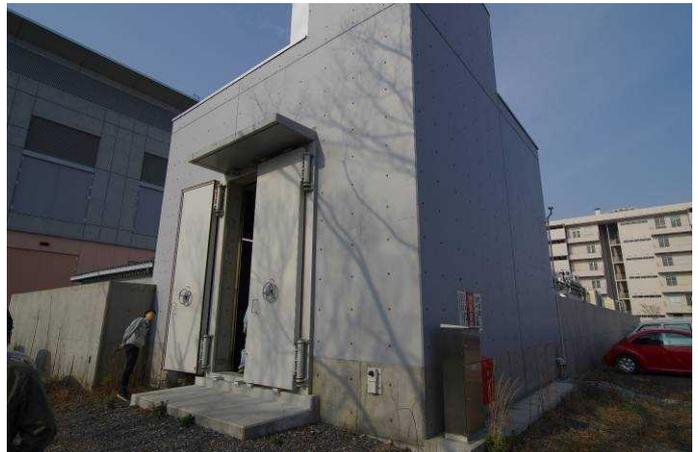
図1: 500kVA の発電機を設置している防潮堤
