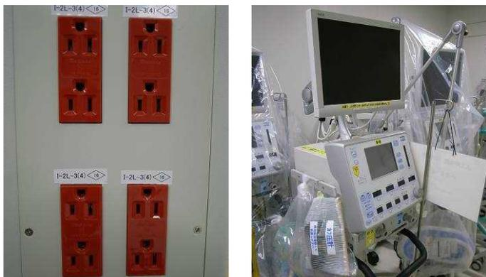
図2:無停電コンセント(左)に接続した心電図モニタ・人工呼吸器(右)
