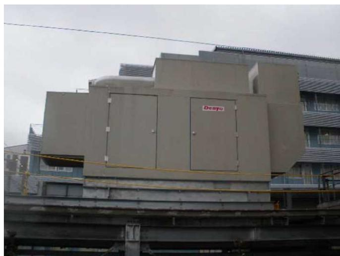
図3：架台上に設置した電子カルテサーバー用の自家用発電機
