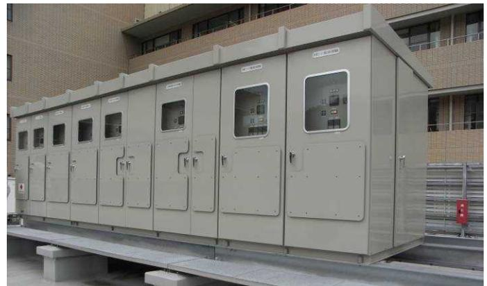
図2: 4階に設置した医療用・非常時熱源用の変電設備
