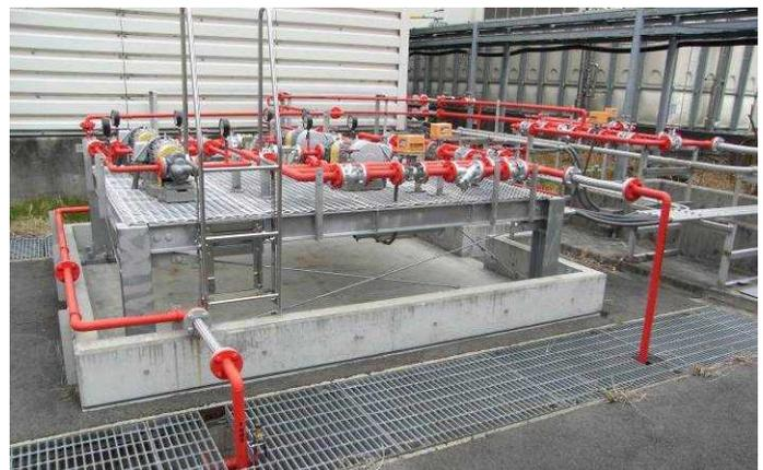
図4: 架台の上に嵩上げ配管を行った燃料移送ポンプ
