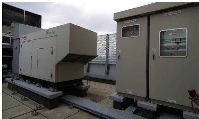
図2: C病棟屋上に設置した専用の375kVA低圧非常用発電機
