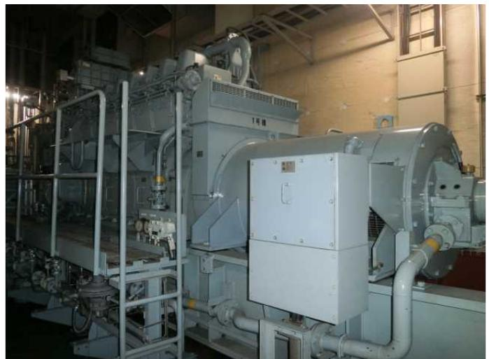
図3: 水冷式の常用発電機(1,050kW)
