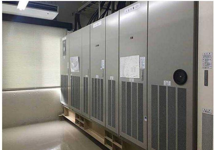
図1:放射線部門用の300kVAの無停電電源設備
