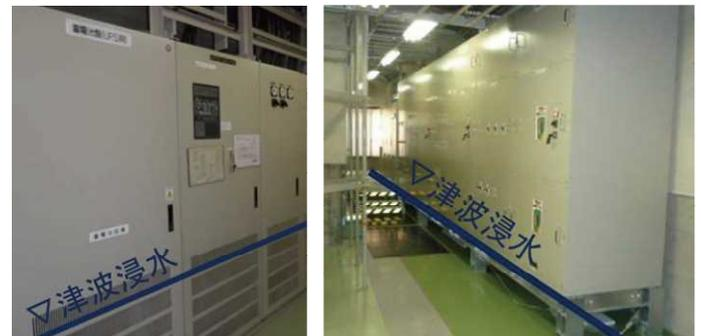
図3: 無停電電源設備の嵩上げ(左:工事前、右:工事後)
