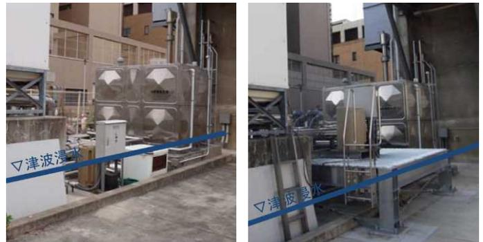
図3: 冷却水循環ポンプの嵩上げ(左: 工事前、右: 工事後)
