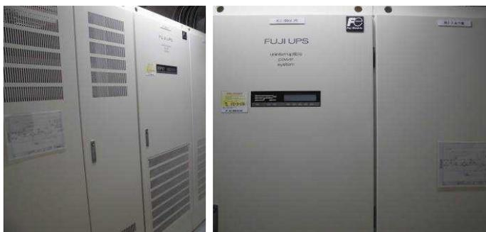
図1:病棟診療棟12階の電気室に設置した無停電電源設備
