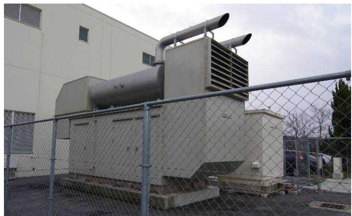
図3: 平成 26 年に新設した 750kVA の非常用発電機
