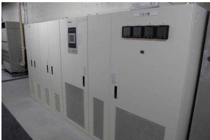
図3:外来診療棟屋上階の電気室に設置した無停電電源設備
