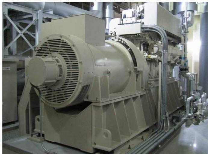
図3: 自家発電設備棟内に新設した 1500kVA の自家用発電機
