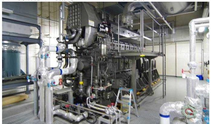
図3: エネルギーセンター2階に移設された 1,500kVA の発電機
