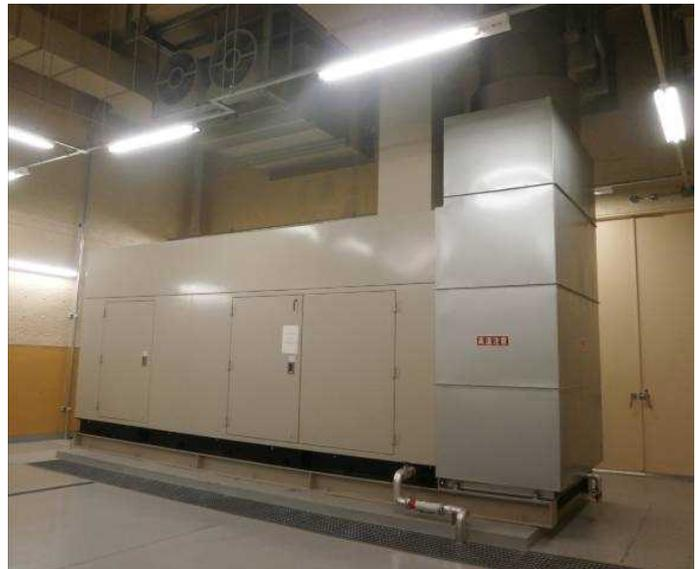
図2: 空冷式の非常用発電機(1,600kW)
