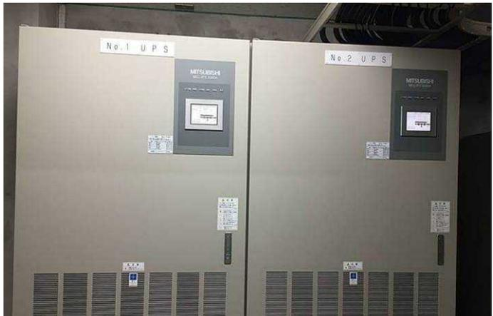
図2:手術・ICU部門用の無停電電源設備(100kVA2台)の制御盤
