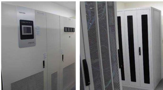
図4:外来診療棟4階の無停電電源装置(左)と電算機室(右)
