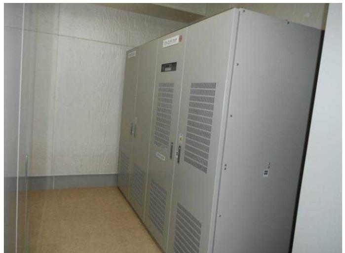
図4: 救急部門に自立運転で電源供給できる蓄電池設備
