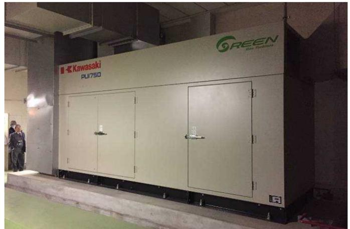
図2: 平成 20 年に設置した 1750kVA の発電機(ガスタービン・空冷式)
