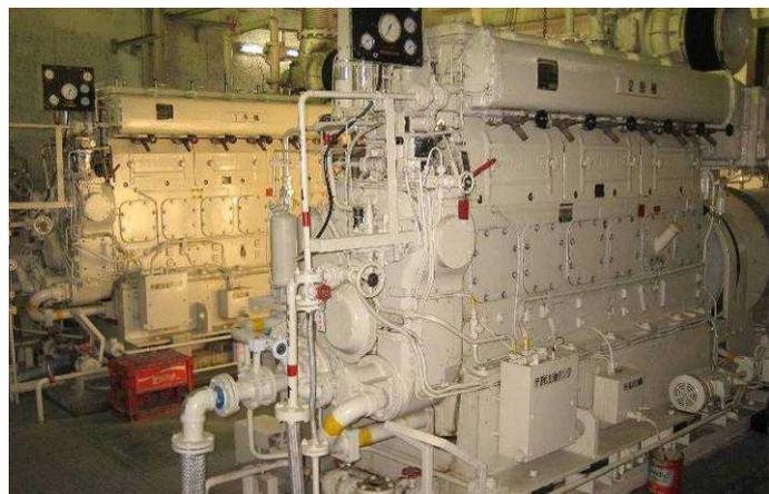
図4: 放射線部門への優先供給が可能な 750kVA の自家用発電機
