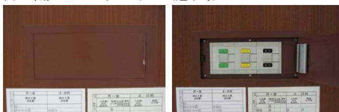
図2: 柱と同色のアウトレットカバー(左:通常時、右:使用時)
