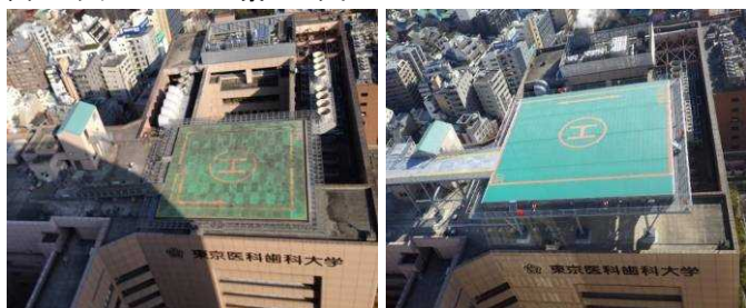
図2: ヘリポート改修前後の俯瞰写真(左: 改修前, 右: 改修後)
