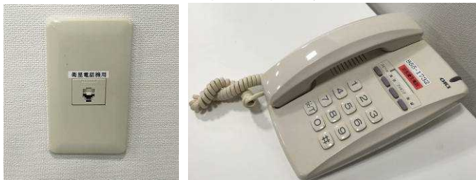
図3: “けやきプラザ”の衛星電話回線と災害優先電話
