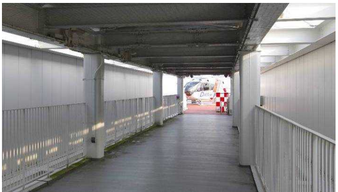
図5: ヘリポートとエレベーター搬送ホールをつなぐ連絡通路
