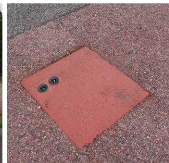
図5: 照明設備設置用の基礎・配管
