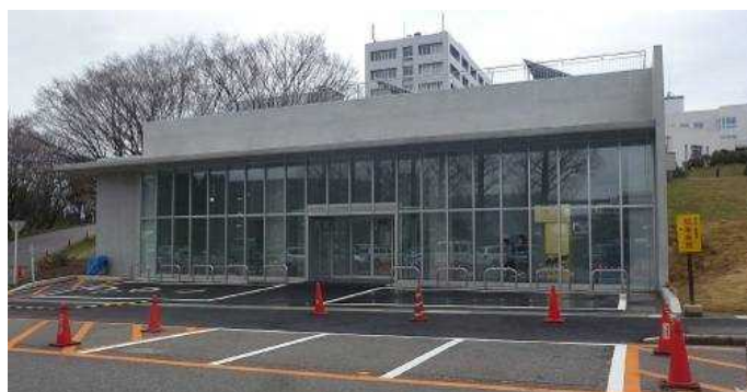
図2: 災害対策プラザの外観
