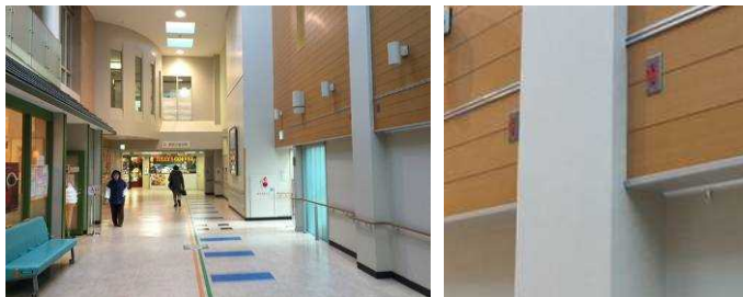
図4: 壁面に非常用コンセントを多数設置したホスピタルモール
