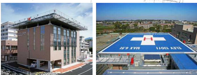
図2: 救命救急センター・ヘリポート棟（左）と屋上ヘリポート（右）
