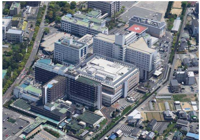
図1: 病棟診療棟の屋上に新設されたヘリポート(手前が既存病院)
