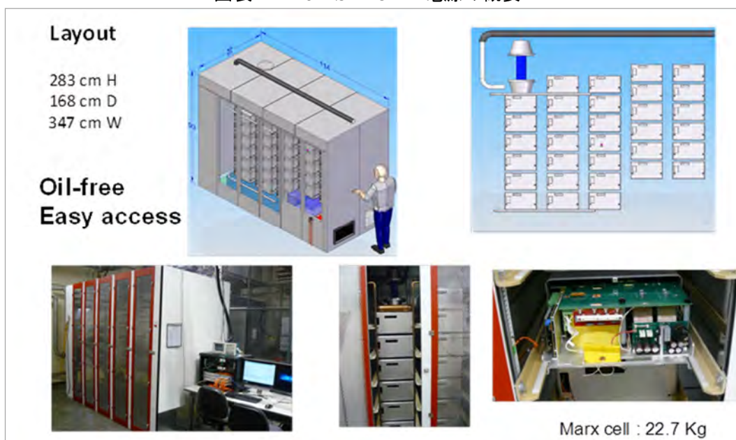
図表 II-29 SLAC-P2 電源の概要
