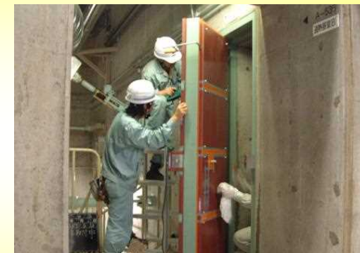
〔断熱材の取付工事〕
