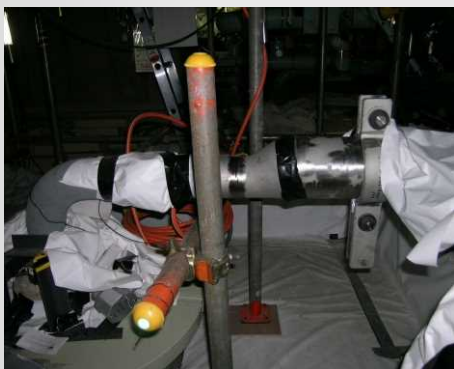
〔ナトリウム抜き取り(ドレン)配管の追加設置〕
