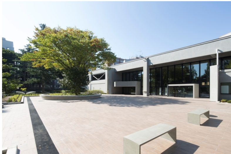
建物 外観写真
