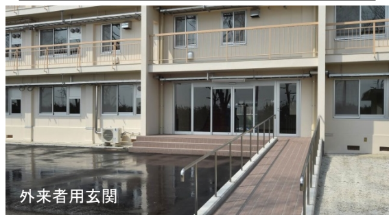
建物外観（耐震補強）
