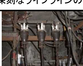
電気ケーブルの劣化
