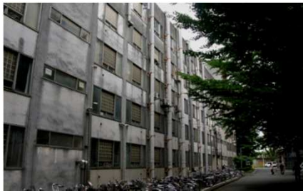
外壁・建具落下の危険
