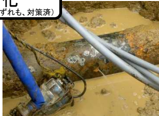
配管からの漏水
