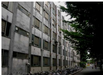
老朽施設の外観(築48年)(東工大)
