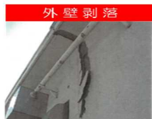
■外壁 経年46年 外壁が経年劣化により亀裂を生じ剥落。
