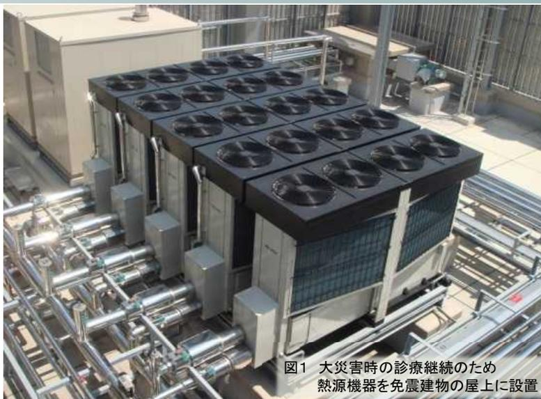
図1 大災害時の診療継続のため熱源機器を免震建物の屋上に設置
