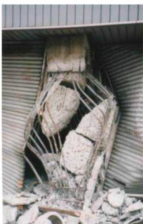
柱のせん断破壊
