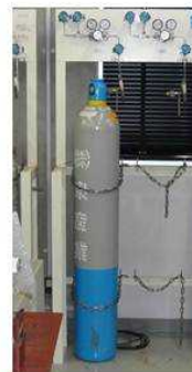
2点で固定されたボンベ
