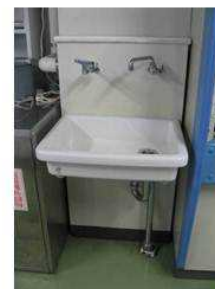
洗面器と洗眼装置を一体的に設置
