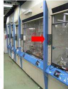
面風速を表示し、可変風量制御されているドラフトチャンバー
