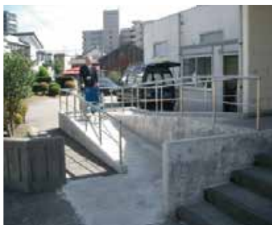
①スロープの設置
