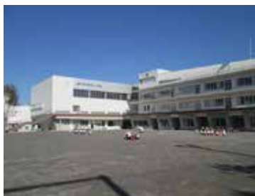
①② 2階の屋内運動場と屋外階段 (江戸川区提供)
