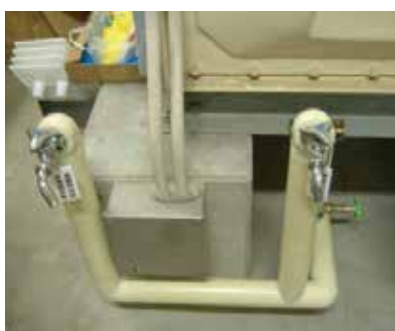
④受水槽への蛇口の設置
