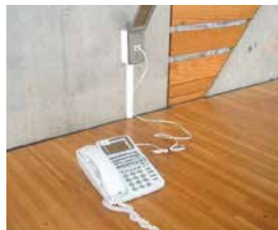
③屋内運動場への電話回線の設置
