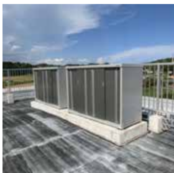
屋上の備蓄倉庫（竹島小学校）
