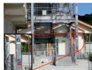
屋外避難階段の柱に設けた標高表示
