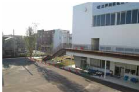
2階の屋内運動場、屋外階段 (江戸川区提供)
