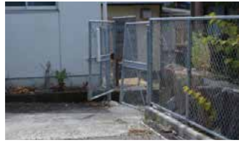
フェンスに新設した門 (南郷小学校)
