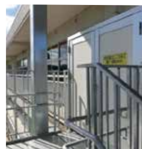
2階から直接屋外階段に 避難可能（竹島小学校）
