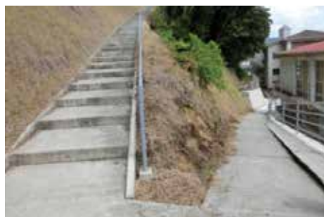
学校の裏山への避難路（左側は階段、右側はスロープ）
