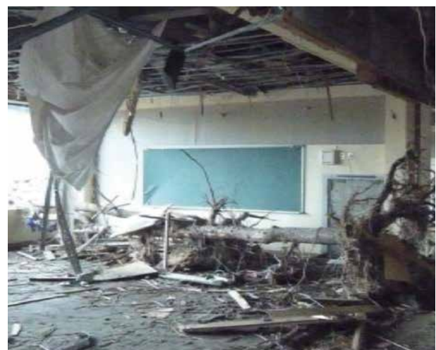
津波の水圧により壁が喪失した教室
