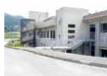
校舎2階と市道をつなぐ非常用通路
