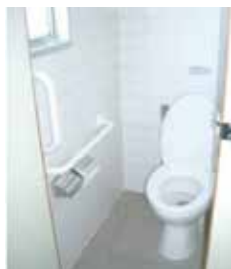
②屋内運動場トイレの洋式化
