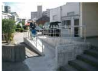
①スロープの設置
