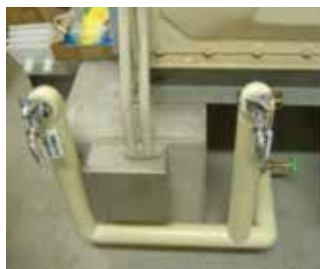
④受水槽への蛇口の設置
