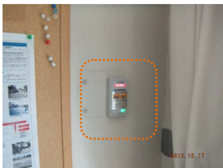
写真①：防犯上の配慮から、民間警備会社による防犯対策。
