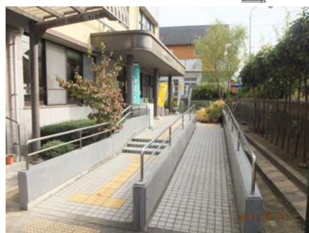
写真③：高齢者・障害者等の利用に配慮した玄関前のスロープ及び誘導ブロックの設置。
