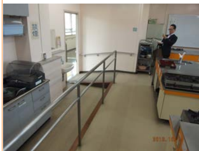
写真④：高齢者・障害者等の利用に配慮し、調理室入口にスロープを整備。
