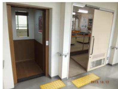
写真⑤：高齢者・障害者等の利用に配慮し、エレベータ及び誘導ブロックを設置。
