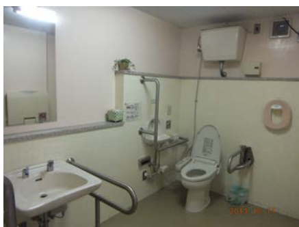
写真②：高齢者・障害者等の利用に配慮した多目的トイレの整備。
