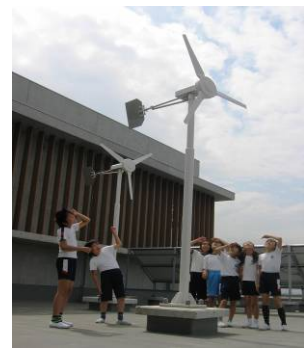
<富山県富山市立中央小学校> 校舎屋上に設置された風力発電
