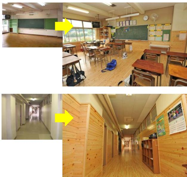
写真1 改修による内装木質化の例とかがわ町立都幾川中学校（埼玉県）
