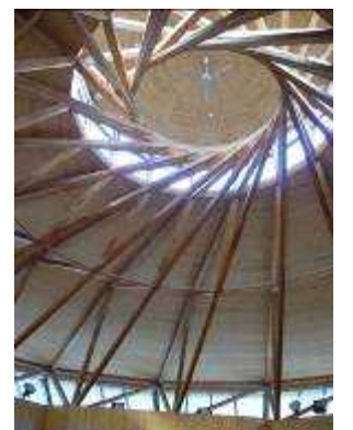
図 6 多目的ホール屋根架構
