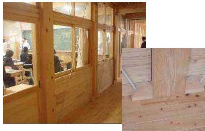
図 2 廊下丸鋼ブレースと脚下納まり
