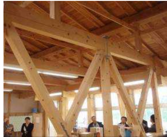
図 3 露出の木筋交による耐力壁（図書室）
