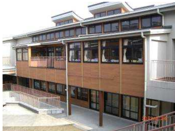
図 1 木造部分の外観
