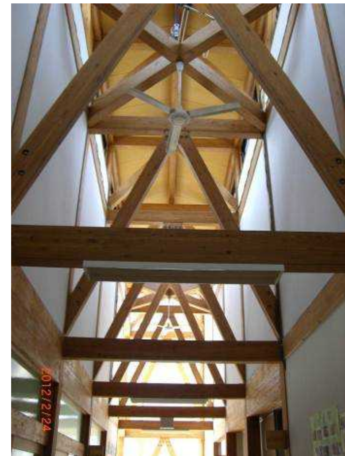
図 5 普通教室前の廊下上部
