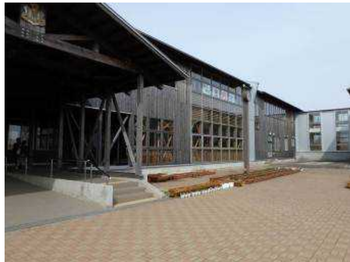
図 1 外観（中央奥に防火壁）
