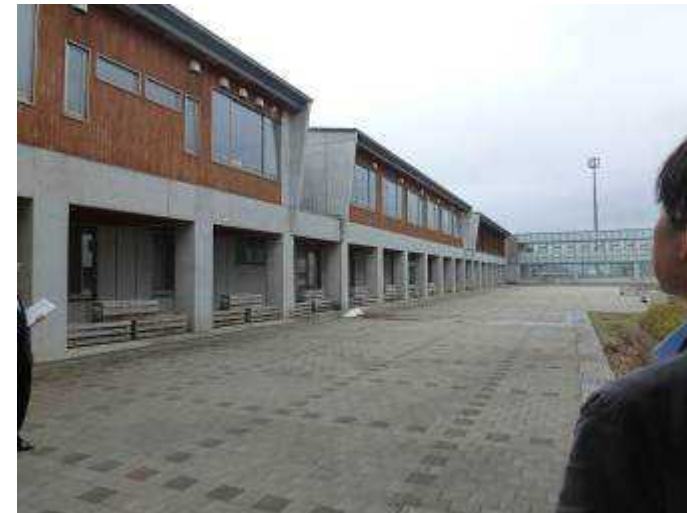
図 3 中学・管理棟外観
