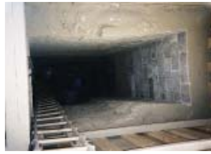
地下室の入り口
