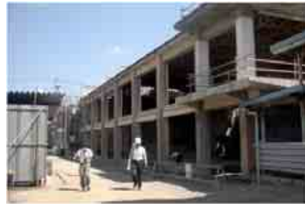
図4 改修中の風景
