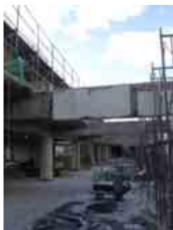
ひかりのみち部分 解体状況
