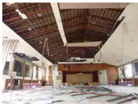
在来工法による天井の地震被害
