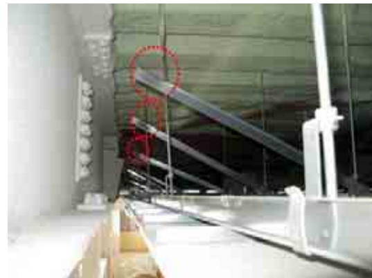
斜め部材の溶接が外れた被害
