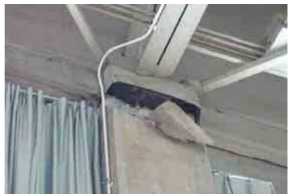
鉄骨屋根定着部コンクリートの破壊
