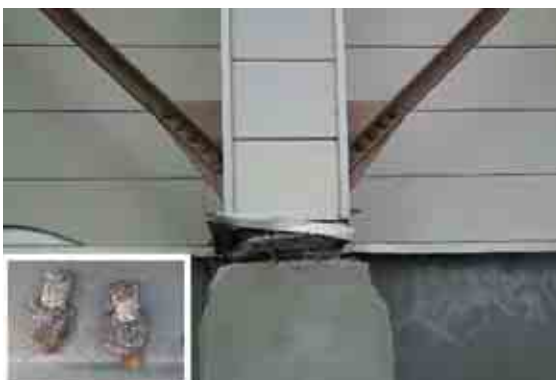
柱脚アンカーボルトのねじ部破断
