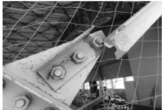
保有耐力接合されていないブレース端接合部の破断
