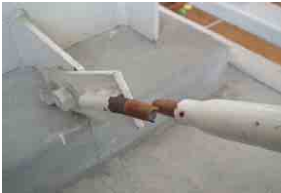
ターンバックルブレースねじ部での早期破断
