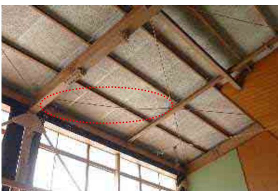
水平ブレースの歪み
