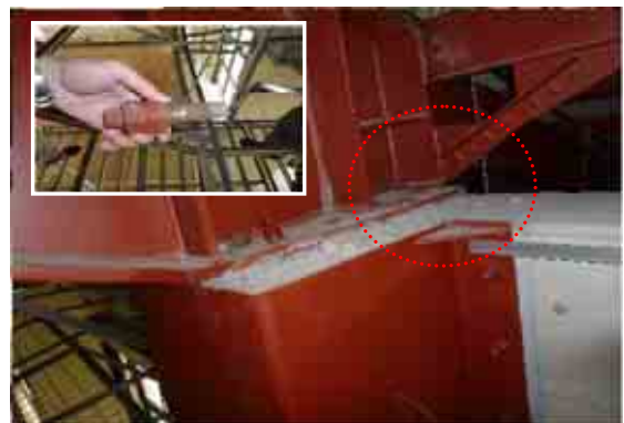
屋根定着部アンカーの破断
