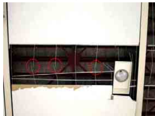
野縁受けの接合箇所(金具接合)の外れ
