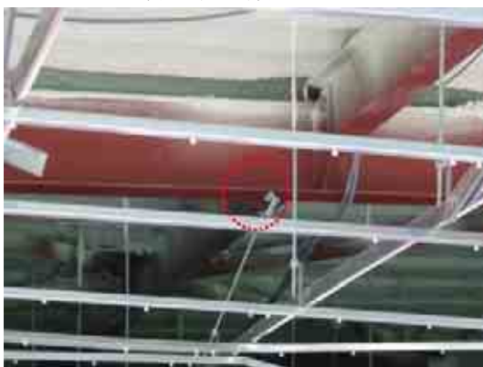
H形鋼梁への吊り金具が外れた被害
