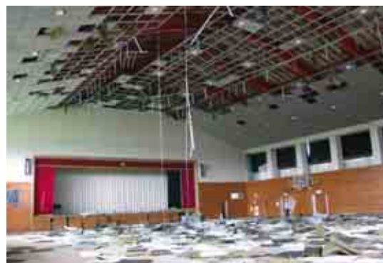
システム天井の地震被害
