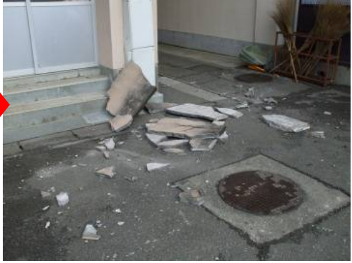
モルタル片が落下 (築31年)
