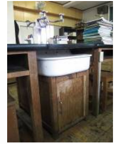
度重なる配管の破損
