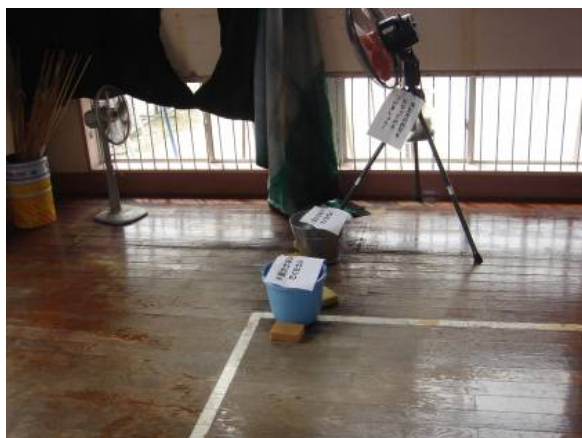
雨漏りにより天井板と床板が損傷(築29年)
