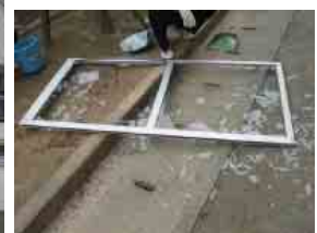
落下して破損した障子
