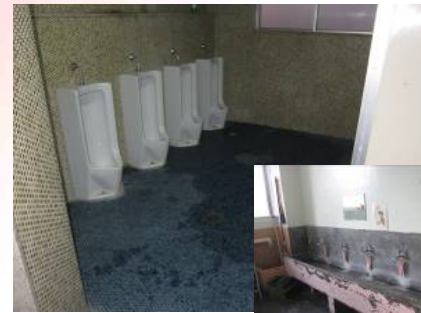
トイレの老朽化による臭気
