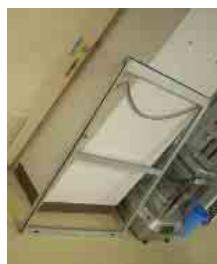
落下した障子
