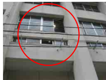
障子の落下箇所
