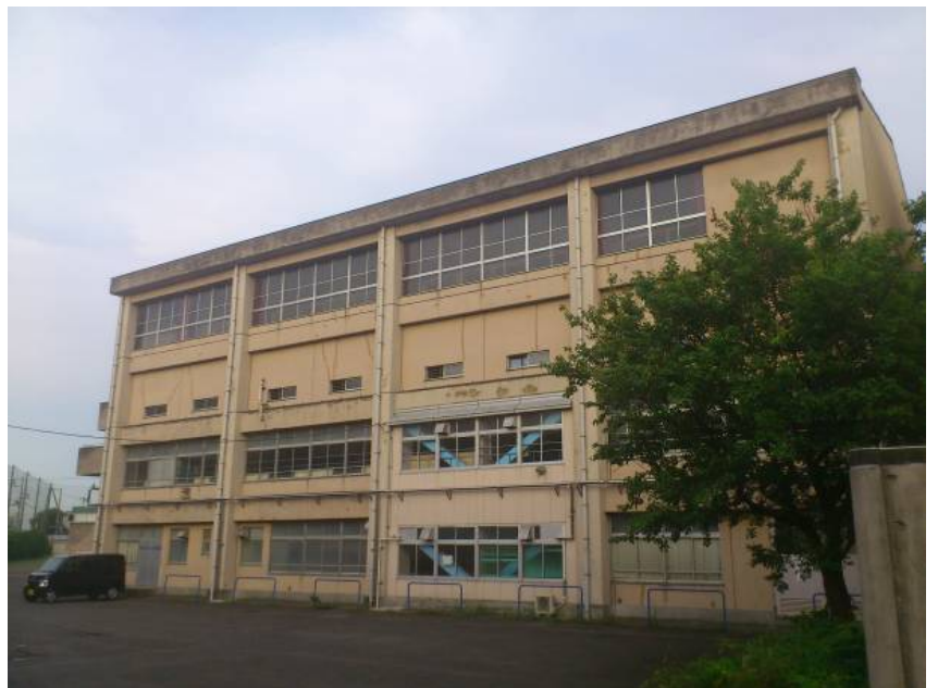
耐震化は終了しているもの の老朽化が著しい外観
