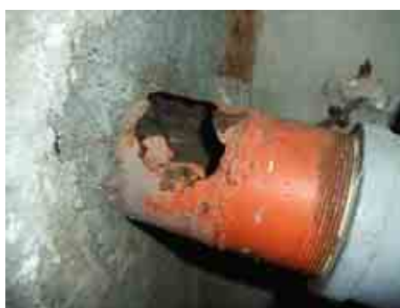
劣化による配管の破損
