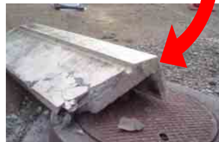
老朽化による手すりの落下
